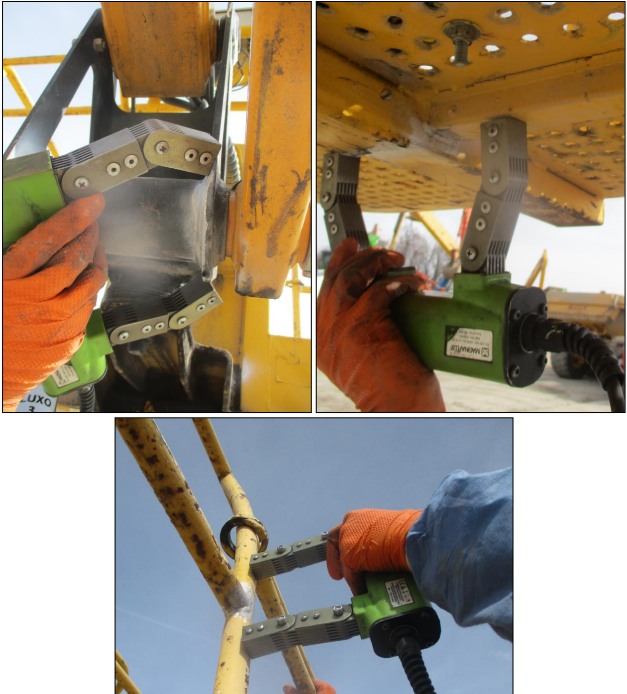
Figure 16 / 17 / 18 - Prove magnetoscopiche eseguite sulle saldature
