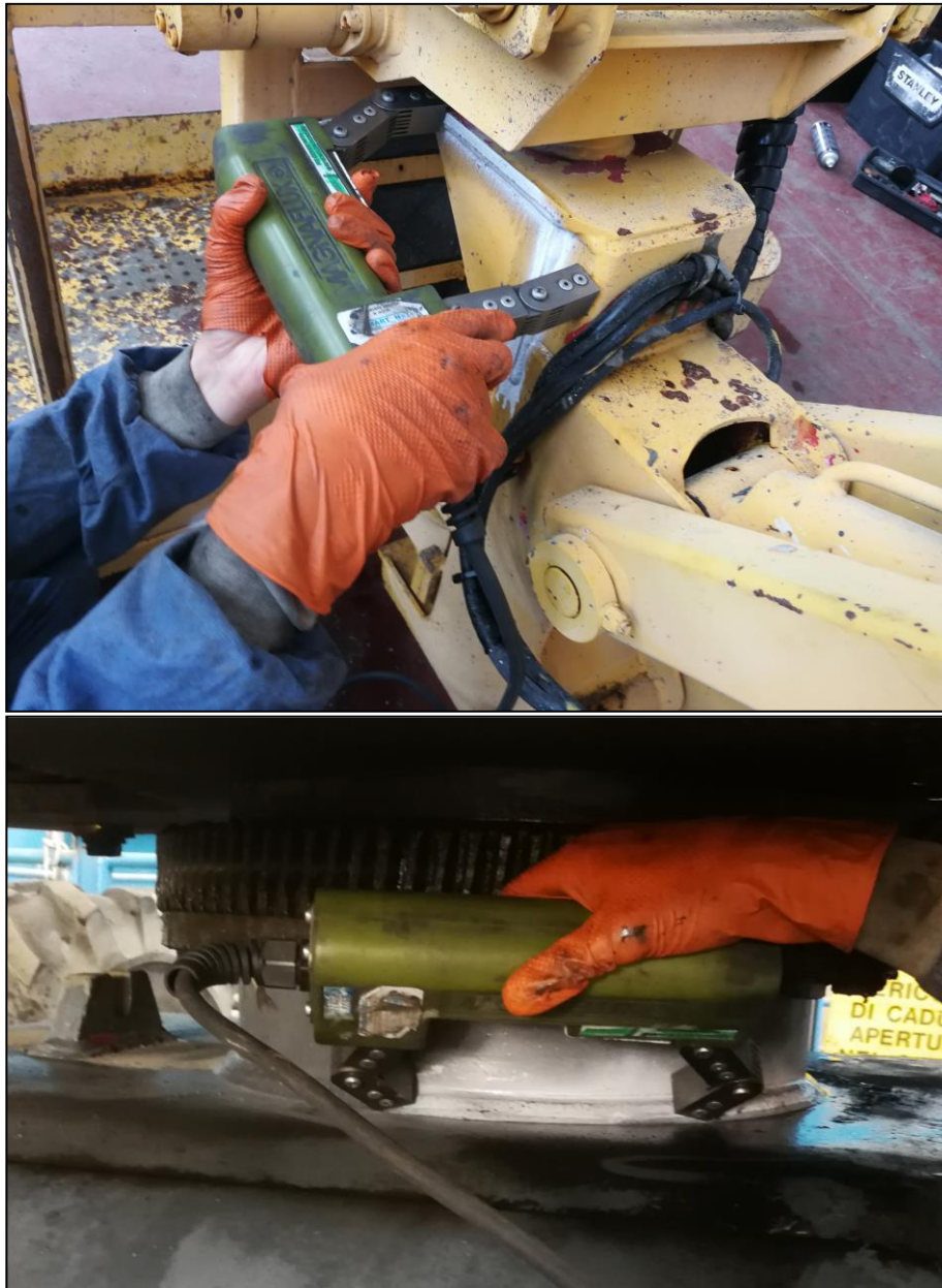
Figure 12 / 13 - Prove magnetoscopiche eseguite sulle saldature
